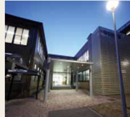
蔵本地区 図書館分館の改修(平成24年3月完成)
