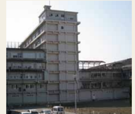
(病院)臨床研究棟等のとりこわし(平成24年3月終了)
